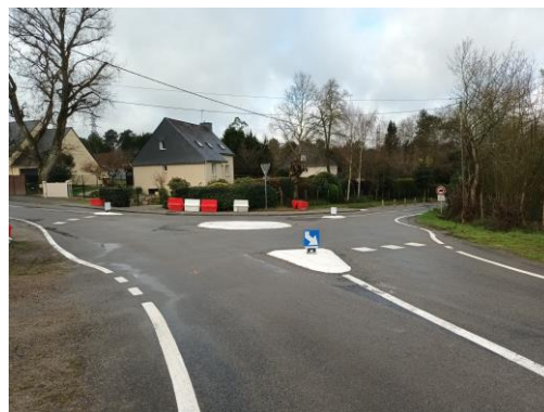
Sécurisation du carrefour de la Rochelle
